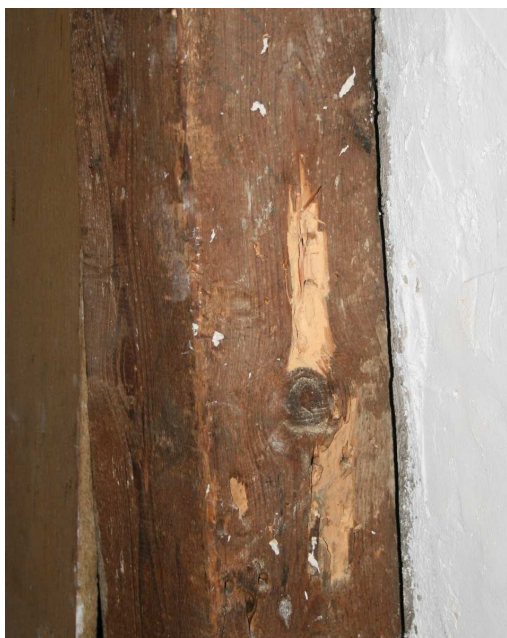
Fot. nr 2 Lokalnie porażone słupy przez owady – techniczne szkodniki drewna
